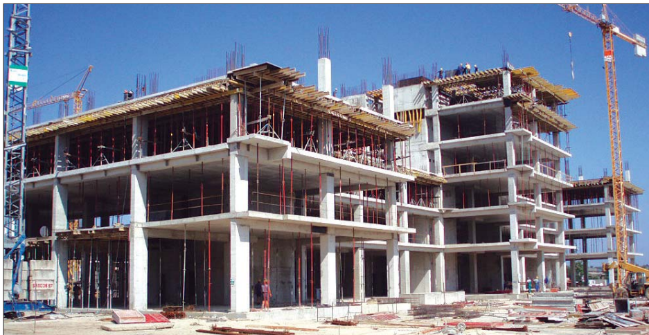
Проектът е в етап груб строеж, като към момента сграда С е на 4-ти етаж, сграда В е на 5-и етаж и сграда А е на 3-ти етаж
